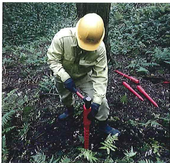
境界杭の設置
