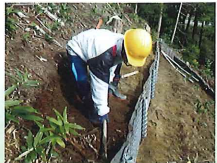
(歩道開設作業)
