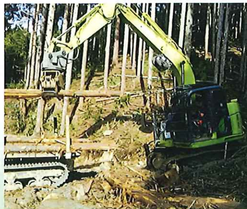
(間伐材の積込み)
