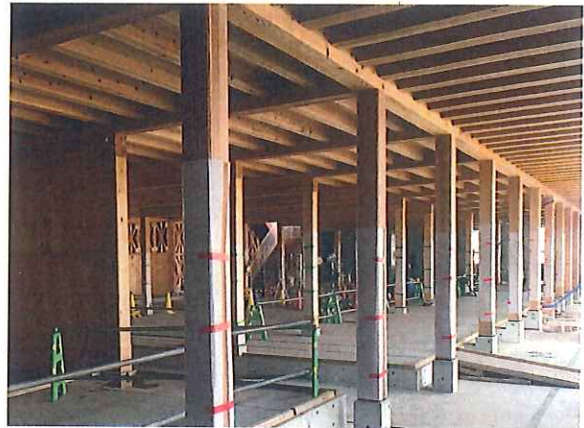
(京丹波町産材の有効利用～町新庁舎建築材)
