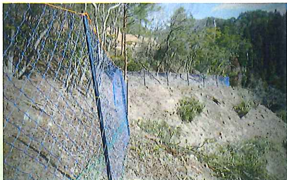
(獣害柵設置状況)
