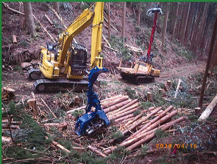
(ハーベスタとフォワーダによる搬出作業中)
