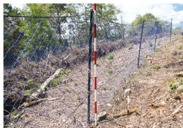
獣害柵の設置
