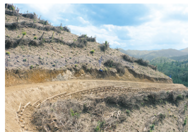
路網（作業道）の整備
