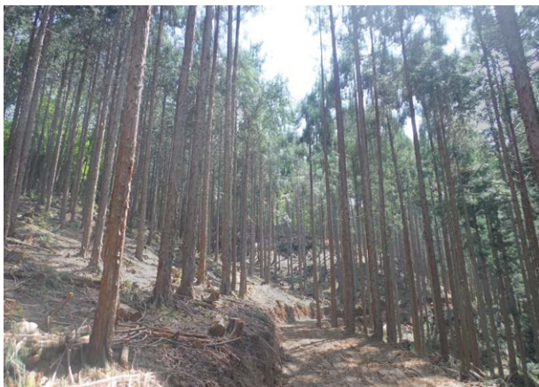
(施工後の林内)
