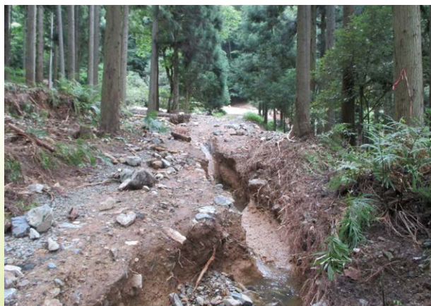
(路面が洗掘された作業道)
