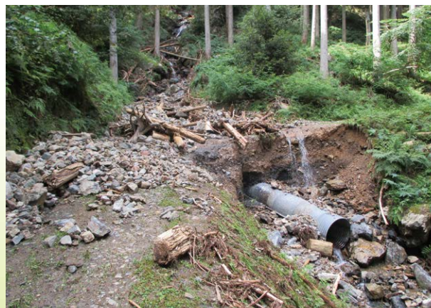
(排水管が詰まり路肩が崩壊した作業道)
